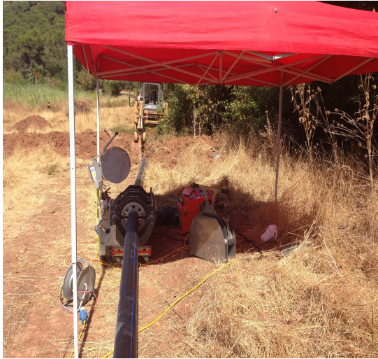
C.M. Setúbal: Empreitada: “REABILITAÇÃO DA REDE DE ABASTECIMENTO DE ÁGUA DO SISTEMA CARRASCAL/CREIRO - 2ª FASE” – Instalação de PEAD DN 140 PN16 MRS100 SDR11 – 828,00 ml em Vala e 785,00 ml através do processo de “Sliplining”.
